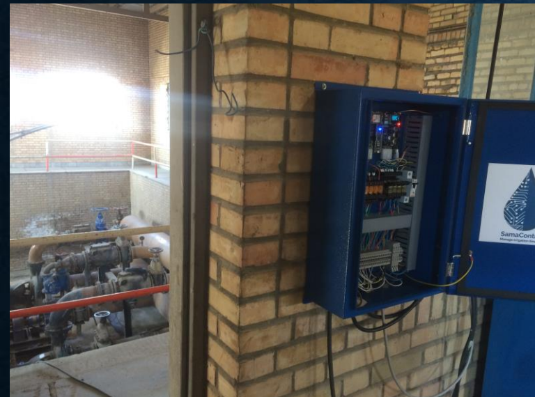
سامانه کنترل و مانیتورینگ تصفیه خانه آستان قدس رضوی
