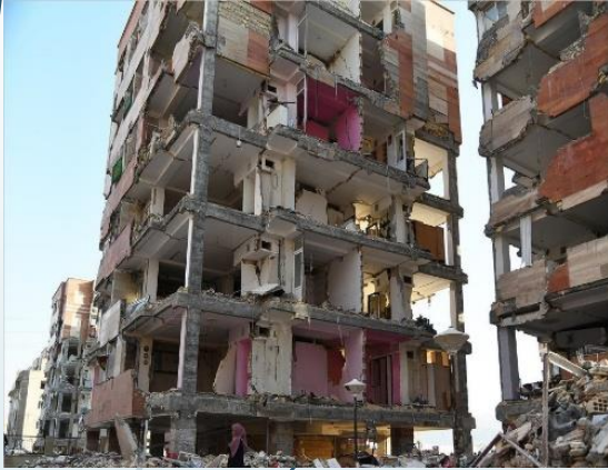
زلزله اخیر کرمانشاه و ریزش دیوار غیرباربر
